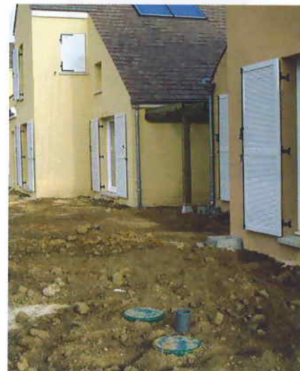
La cuve de récupération des eaux de pluie est enterrée dans la parcelle de jardin individuel
