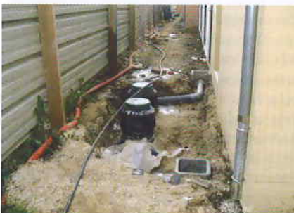
La cuve de récupération des eaux de pluie est enterrée dans la parcelle de jardin individuel
