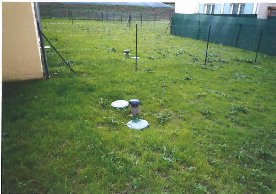
La cuve de récupération des eaux de pluie est enterrée dans la parcelle de jardin individuel
